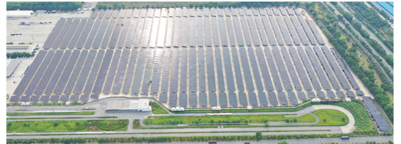
▲ 旗下东风柳州汽车有限公司光伏建设
